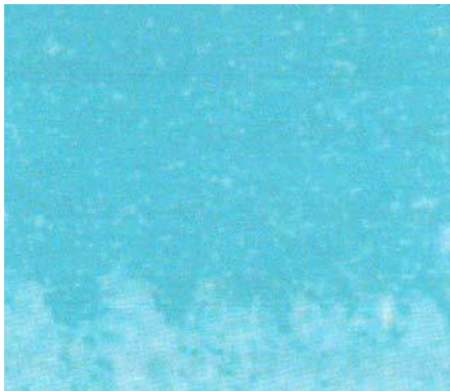
Рис. 1. Затек воды на элементе контрольной шкалы
