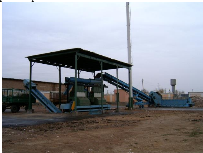
Рис.1. Батарея из двух очистителей хлопка-сырца с транспортными средствами для подачи и отвода хлопка-сырца и сорных примесей
