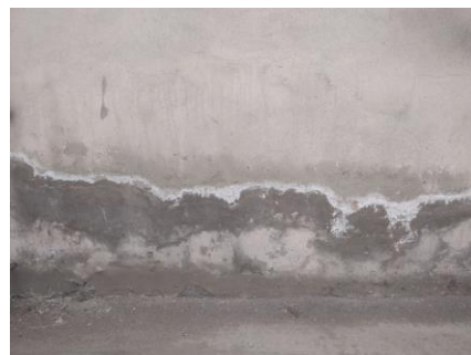
1-расм. ТТЕСИ устахонаси ва ўқув биноси деворларининг фундамет қисмига грунт суви ва тузнинг таъсири кўриниши
